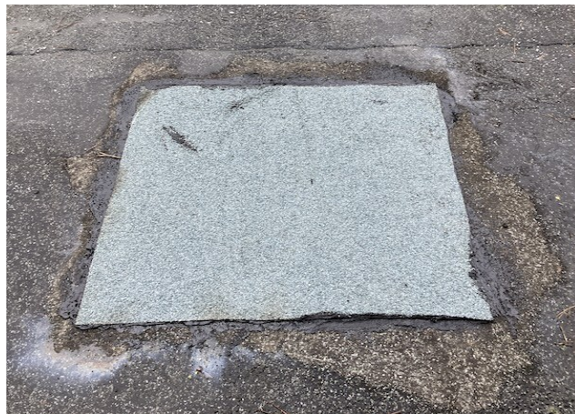
foto /10/ Pohled na zapravenou sondu S3
