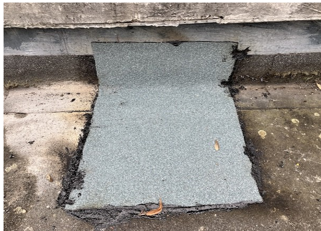
foto /8/ Pohled na zapravenou sondu S2
